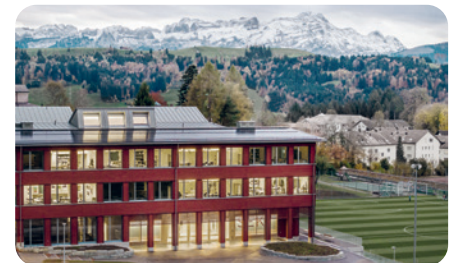
Schulhaus Landhaus, Teufen/AR (© Kurzschniss)
