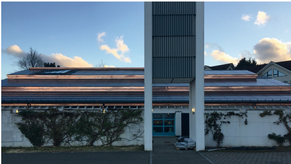
3 L'isolation améliorée et les modules PVT assurent un excédent de courant solaire de 63'000 kWh/a.
