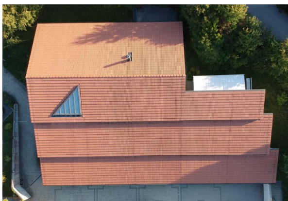
2 Vue du toit de l'église avant rénovation.
