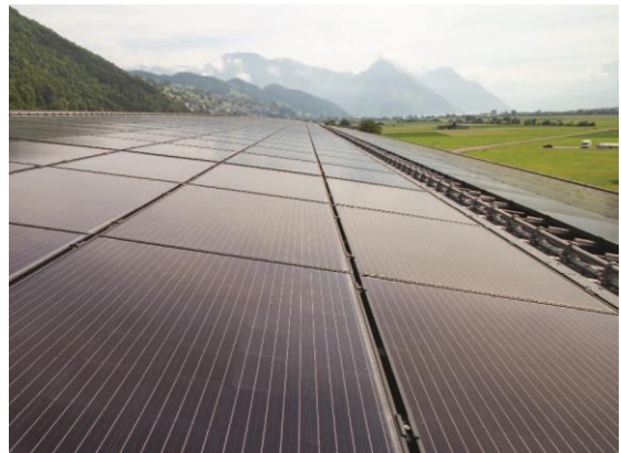
Abb. 2: Die 1.05 starke und gut auf dem leicht gewölbten Bogendach PlusEnergie-Industriehalle montierte Solaranlage erzeugt jährlich 1.09 GWh CO 2 -freien Solarstrom.
