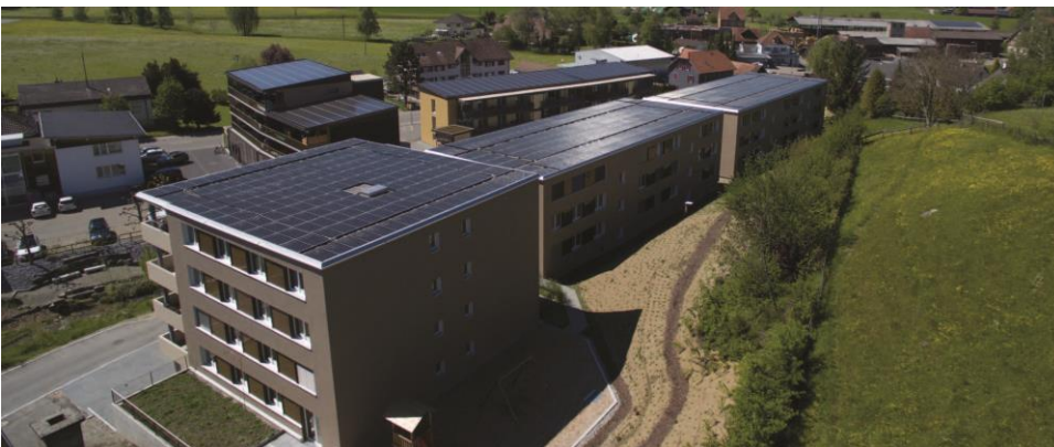
Abb. 2: Die 232.5 kW starke PV-Anlage generiert ca. 209'400 kWh/a CO 2 -freien Solarstrom für alle 32 PEB-Wohnungen und 54 E-Autos. Dieser CO 2 -freie Leuchtturm von europäischer Bedeutung setzt das Pariser Klimaabkommen bereits vollständig um und bildet einen Meilenstein für alle innovativen Pensionskassen, Immobilienfirmen und Bauunternehmungen.
