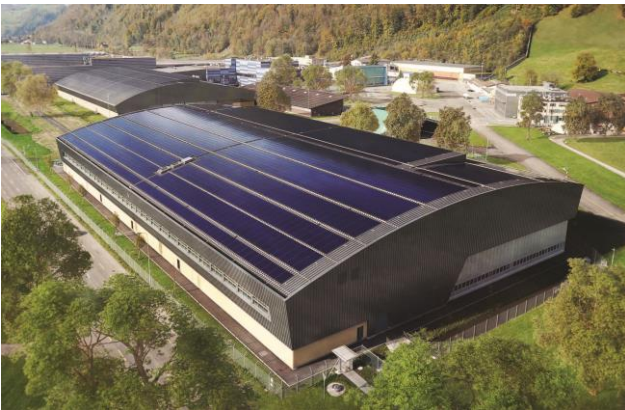
Abb. 1: Ansicht des Pilatus Flugzeugwerke AG Industriebaus von Süden. Die homogene dunkle PV-Anlage der Norman Foster-PlusEnergie-Industrie-halle ist sehr gut integriert.
