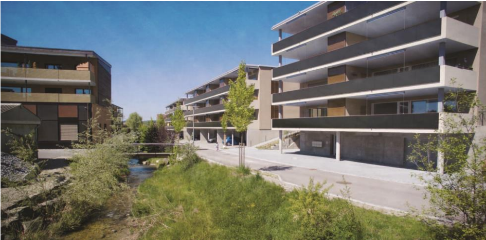
Abb. 1: Die CO 2 -freie MFH-Überbauung Zentrum Tobel/TG mit 32 PEB-Wohnungen zeichnet sich zur solaren Dachnutzung auch durch elegante PV-Balkone aus. Diese PEB-Siedlung garantiert den Mieter/innen 20% tiefere Mietzinse als vergleichbare Wohnungen der Wirtschaftsregion Will/SG (Fertigst. Nov. 2018).
