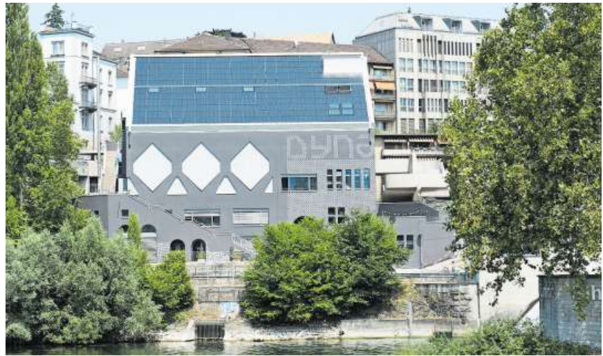
Wurde eigens für das Dynamo in Zürich entwickelt: Solaranlage auf dem Dach.
