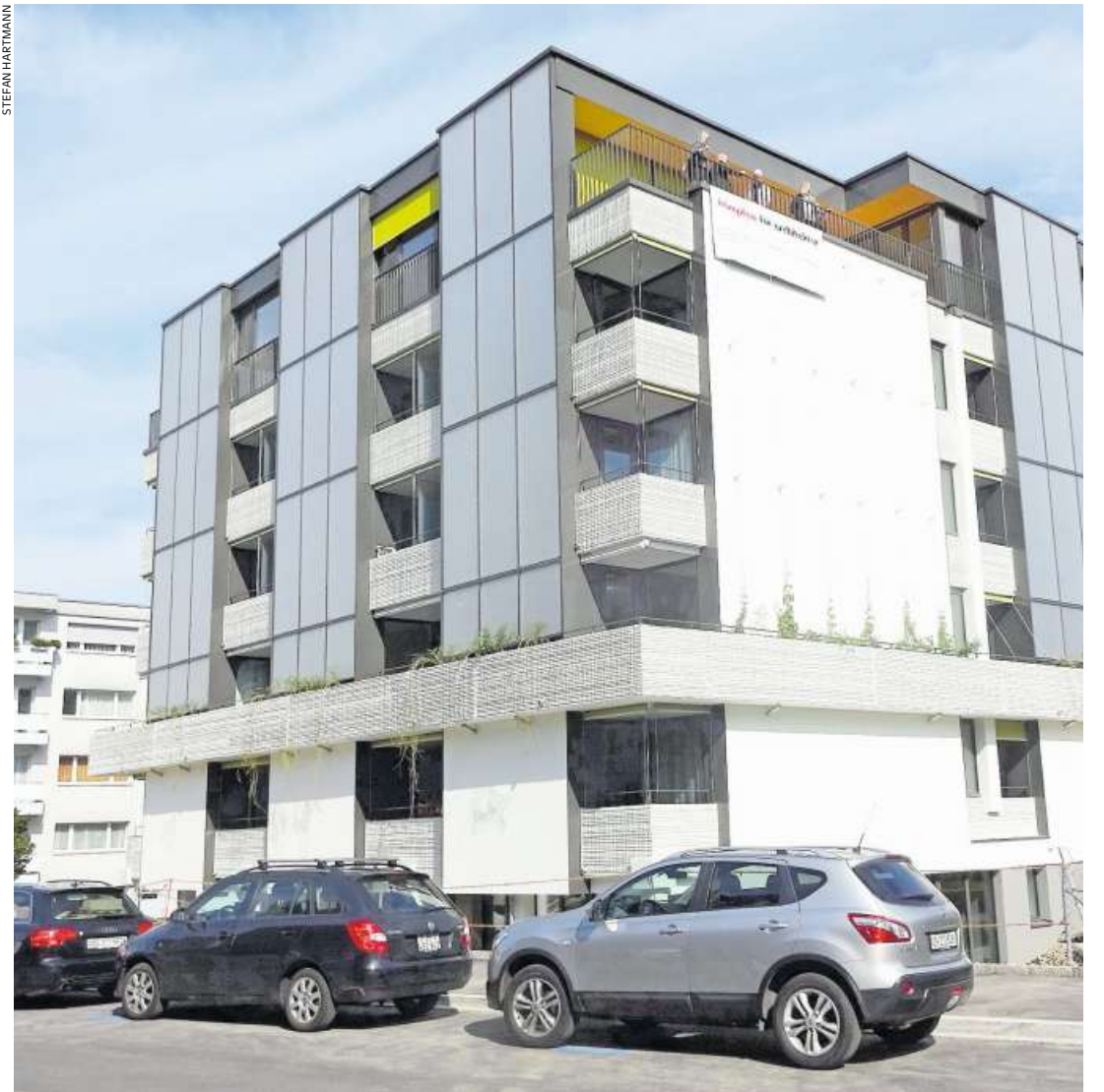
Erste Mehrfamilienhaus-Sanierung nach «Minergie A» mit Solarfassade in Zürich Schwamendingen.
