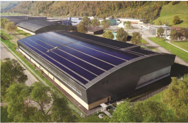
Illustr. 1: Vue de l'usine Pilatus Constructions aéronautiques SA depuis le sud. Les panneaux PV foncés et homogènes de la halle industrielle à énergie positive Norman Foster sont très bien intégrés.
