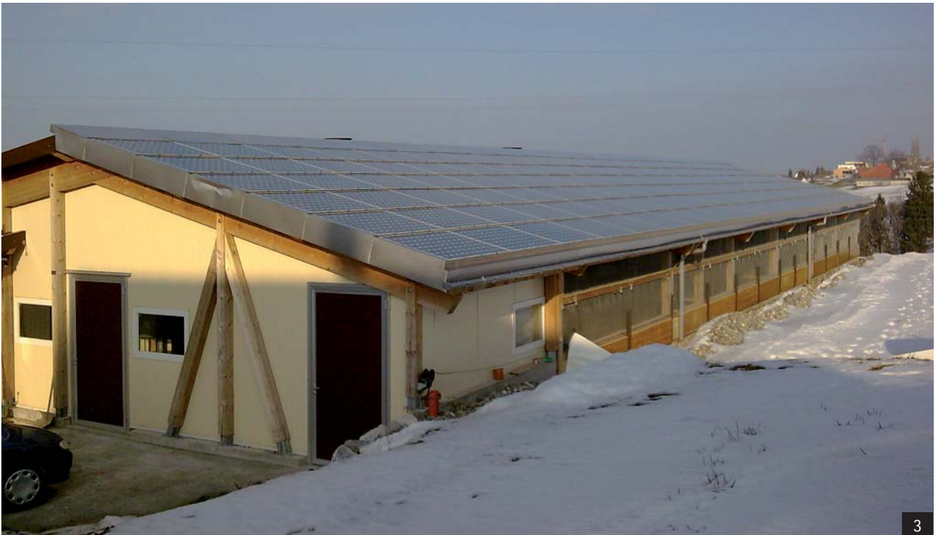
1: Berney, LesBioux (VD), 40 kWp, production annuelle: environ 40'000 kWh. 2: Rüfenacht, Longirod (VD), 45 kWp, production annuelle: environ 45'000 kWh. 3: Pittet, Villarod (FR), 30 kWp, production annuelle: environ 30'000kWh (Photos: Sunwatt Bio).
