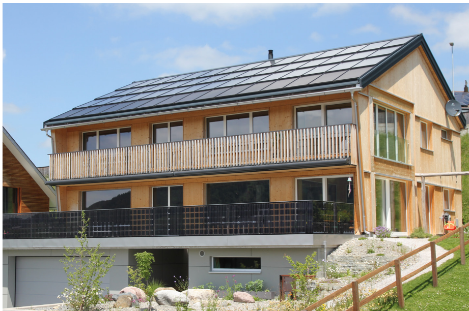
1 Das im traditionellen Appenzeller Holzbaustil errichtete Gebäude mit vorbildlich integriertem Solardach produziert jährlich ca. 17'200 kWh
