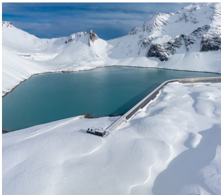
1 Grossbildaufnahme des Pumpspeicherkraftwerks PSKW Linth-Limmern, mit Speichersee und alpinem Hintergrund.
