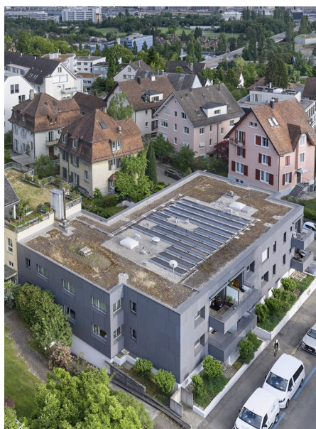
2 Die PV-Anlage produziert ca. 12'600 kWh/a und deckt mit der Fassade 57% des Gesamtenergiebedarfs des Gebäudes.
