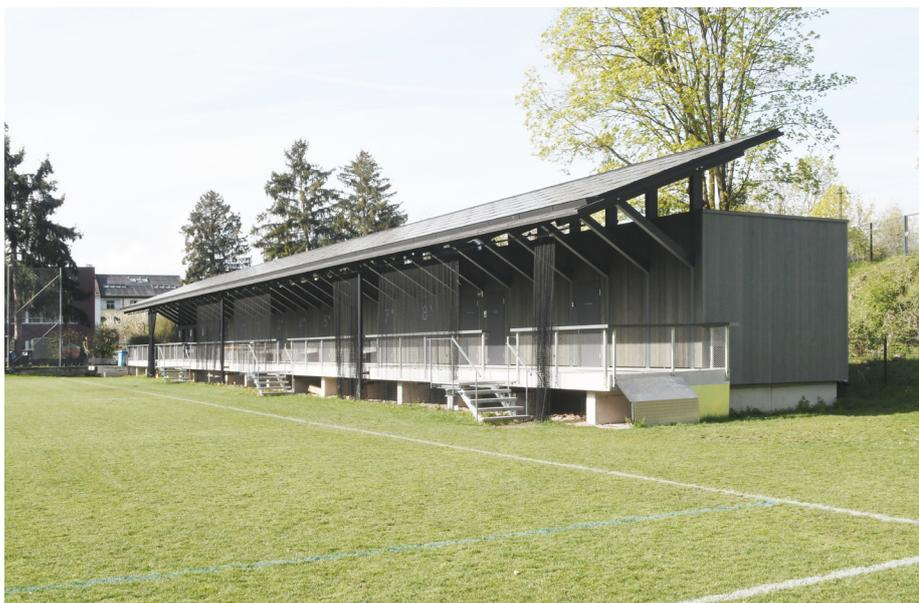
1 Die im Dach integrierten PV-Anlagen dienen nicht nur als emissionsfreie Energieversorgung mit einem Eigenversorgungsgrad von 97%, sondern vielmehr auch als Vordach für die Anlage.
