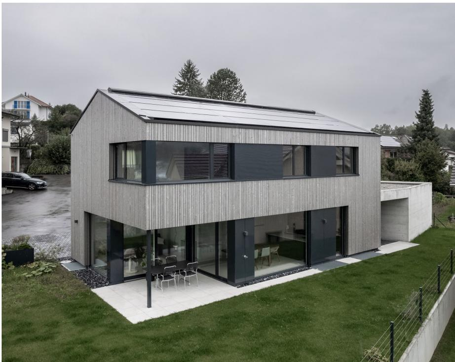
1 Die dachbündig nach Ost-West ausgerichtete Solaranlage fügt sich harmonisch in die Gebäudehülle ein und produziert mit jährlich 12'600 kWh 214% des gesamten Eigenverbrauchs. Damit könnten mehr als vier E-Autos jährlich je 10'000 km CO<sub>2</sub>-frei fahren.
