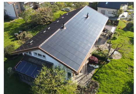
1 Dank der Nachdämmung von Dach und Fassade konnte der Gesamtenergiebedarf auf 13'918 kWh/a reduziert werden.
