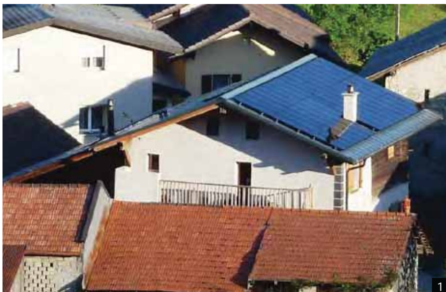
1: Au centre, la maison Thissen rénovée, après le montage de l'installation solaire.
