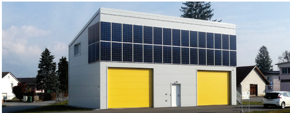
Das solarbetriebene Gewerbegebäude läuft als eines der ersten Industriegebäude weltweit ausschliesslich mit vom Gebäude produzierten und im Gebäude gespeichertem Solarstrom.
