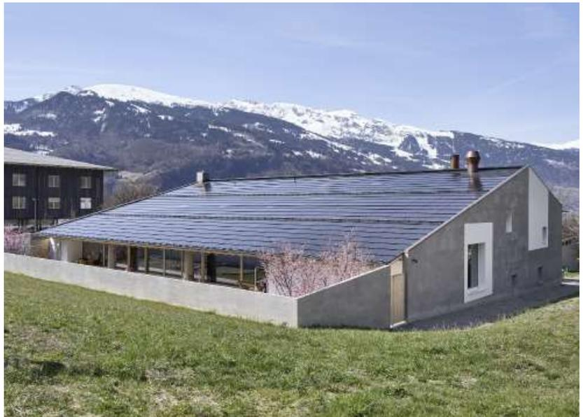
**Abb. 2:** Bei der Sanierung des PEB-Mehrzweckgebäudes in Fläsch/GR wurde die Energiebezugsfläche verdoppelt. Dank der guten Dämmung stieg der Gesamtenergiebedarf nur um 5'500 kWh/a auf **65'440 kWh/a**. Die **275%-Eigenenergieversorgung** sorgt für einen **Solarstromüberschuss von 114'240 kWh/a**. Damit können **81 Elektroautos** jährlich 10'000 km emissionsfrei fahren.
