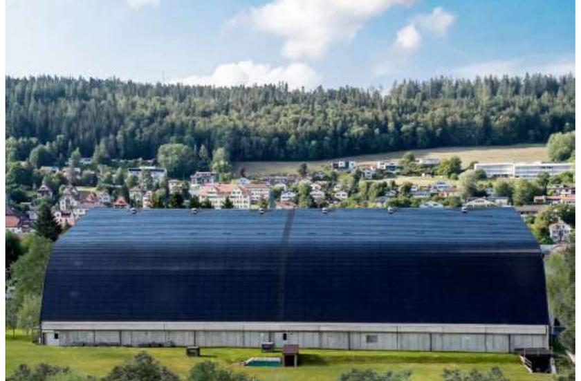
**Abb. 1:** Die 2018 sanierte **104% PEB-Eiskunsthalle** in Tramelan/BE produziert jährlich **435'030 kWh**. Damit deckt sie den Eigenenergiebedarf von **418'470 kWh/a** um 104%. Mit dem Solarstromüberschuss von 16'560 kWh/a können **11 E-Autos** jährlich 10'000 km CO<sub>2</sub>-frei fahren.
