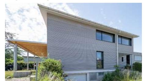
1 Dank der verbesserten Dämmung des Erdgeschosses konnte der Gesamtenergiebedarf um 85% von rund 45'000 kWh/a auf 6'700 kWh/a reduziert werden.
