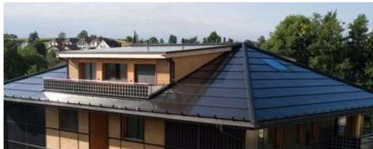
**Abb. 1c:** Min.P gedämmtes PV-Dach mit ganzflächig vorbildlich integrierter Solaranlage, um mehr CO<sub>2</sub>-freien Winterstrom zu generieren.
