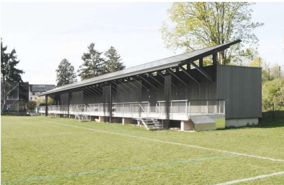
1 Die im Dach integrierten PV-Anlagen dienen nicht nur als emissionsfreie Energieversorgung mit einem Eigenversorgungsgrad von 97%, sondern vielmehr auch als Vordach für die Anlage.
