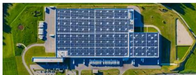
**Abb. 6:** Das perfekt integrierte Solardach des Logistikzentrums in Perlen/LU mit der 6.4 MW PV-Anlage produziert mit jährlich **7.33 GWh** mehr als doppelt so viel wie es benötigt; und mehr als 4 Kleinwasserkraftwerke (KWKW). Mit dem Solarstromüberschuss können 3'000 E-Autos jährlich 12'000 km CO<sub>2</sub>-frei fahren, mit dem gesamten Solarstrom sogar **5'200 E-Autos**. Dies entspricht der **PW-Flotte einer Kleinstadt**.
