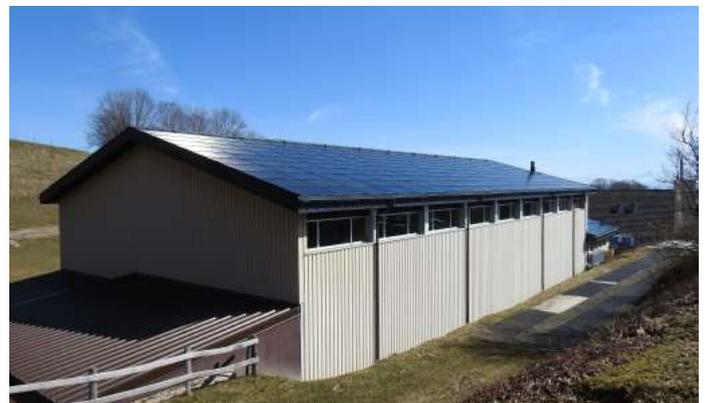
**1** Les systèmes photovoltaïques situés sur les côtés ouest et est du toit produisent jusqu'à 193'800 kWh/a.
