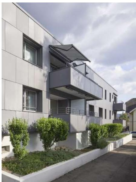
1 Die neu erstellte Fassade mit den integrierten PV-Modulen produziert ca. 14'000 kWh/a.
