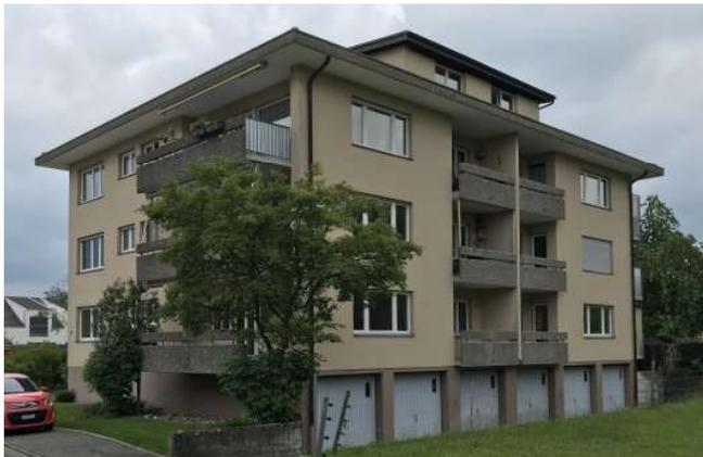
**Abb. 1a:** Durch die Min.P/PEB-Sanierung des 50-jährigen Mehr-familienhauses (MFH) in Fahrwangen sank der Gesamtenergieverbrauch um 82% von 138'000 kWh fossil-nuklearen Energien auf Null bzw. 25'000 kWh/a CO<sub>2</sub>-freien Solarstrom (Abb. 1a: EW-bestätigt, 4.7.2022).
