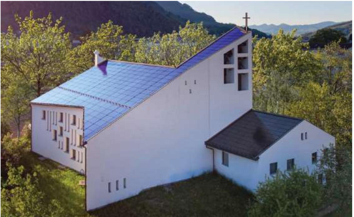
Die 1965 erbaute und denkmalgeschützte Marienkirche in Mollis wurde 2023 saniert und mit einer 44.5 kWp starken Photovoltaikanlage auf dem Dach ausgestattet; dadurch kann sie ihren eigenen Energiebedarf zu 149% decken. Für diese ästhetisch, sowie energetisch nahezu perfekte Sanierung erhält die Kirche den Norman Foster Solar Award 2023.
