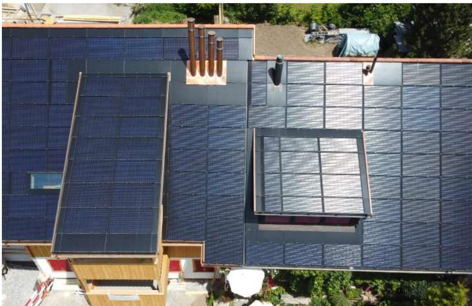
**1** Luftansicht des historisch sanierten Hauses von 1770; die installierten PV-Anlagen generieren mit 29'400 kWh 109% des Eigenverbrauchs.
