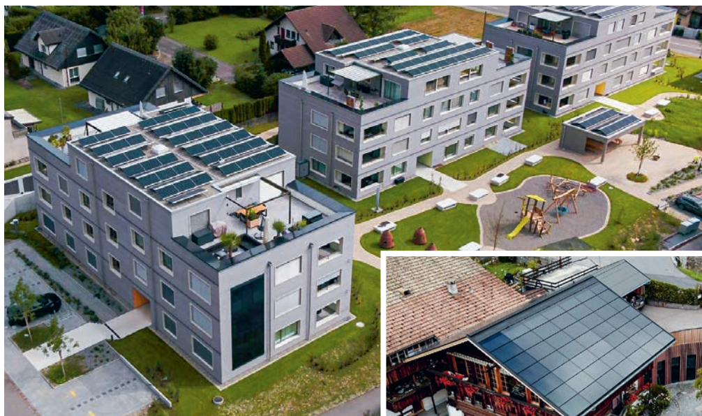
Abb. 1 (oben): Die gut gedämmte 123%-Minergie-P/PlusEnergie-Siedlung in Möriken (AG) benötigt insgesamt 130 200 kWh/a und erzeugt 157 800 kWh. Der Stromüberschuss reicht, um bis zu 20 E-Autos CO 2 -frei zu betreiben. Die Siedlung erhielt den Migros Bank Sondersolarpreis für PEB MFH 2020 (© SAS, Solarpreis 2020).
