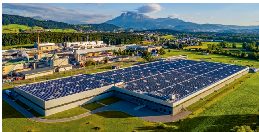
Abb. 4: Das 230%-PlusEnergie-Verteilzentrum in Perlen (LU) erhielt den PlusEnergieBau-Solarpreis 2020. Es produziert mit 7,33 GWh/a doppelt so viel wie der Gesamtverbrauch oder mehr als 4 Kleinwasserkraftwerke zusammen oder Strom für den CO 2 -freien Betrieb der Autoflotte einer Kleinstadt. (© SAS, Solarpreis 2020).
