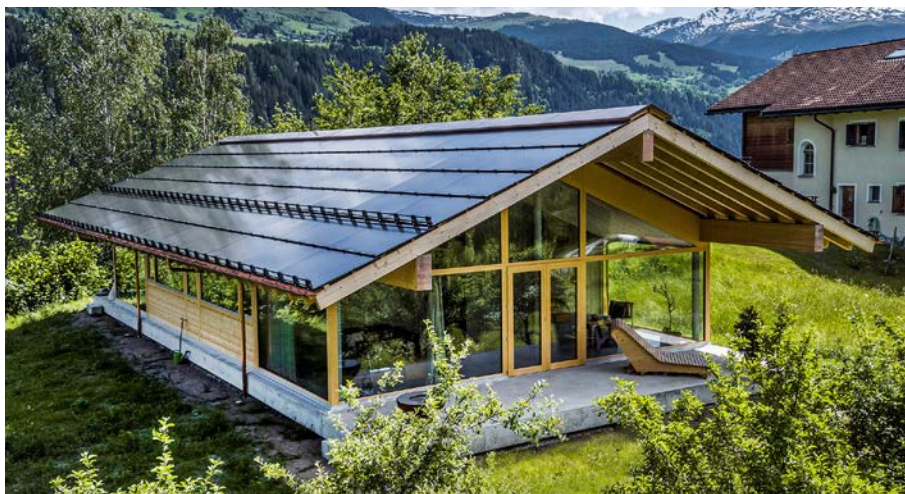
Abb. 3: Das 800%-PlusEnergie-Wohnhaus (Weltrekord) in Waltensburg (GR) gewann den Norman Foster PEB-Solarpreis 2020. Das Haus produziert jährlich 40 200 kWh, benötigt bloss 5000 kWh/a. Mit dem Solarstromüberschuss von 35 200 kWh/a können 25 E-Autos jährlich je 12 000 km CO 2 -frei fahren. (© SAS, Solarpreis 2020).
