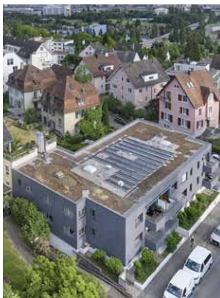
2 Die PV-Anlage produziert ca. 12'600 kWh/a und deckt mit der Fassade 57% des Gesamtenergiebedarfs des Gebäudes.
