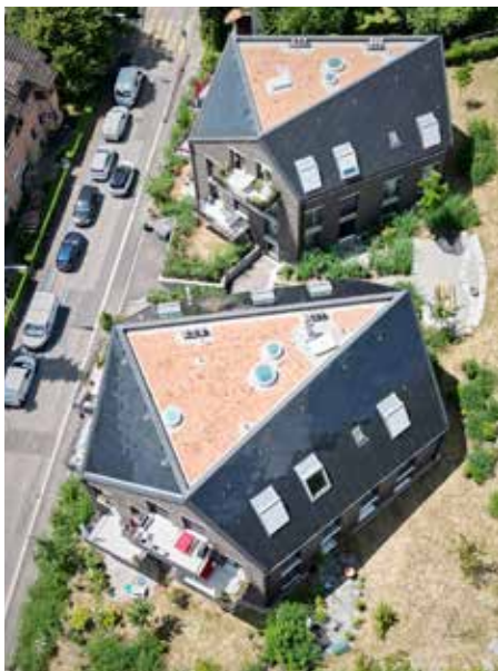
1 Die Luftaufnahme der Gebäude zeigt deren PV-Anlagen auf den Dächern in drei Himmelsrichtungen; diese produzieren 32'600 kWh/a.
