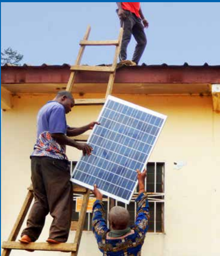
Solafrica setzt sich für die Bildung, Sensibilisierung und den konkreten Zubau von Solaranlagen vor allem in Afrika ein. Auch in der Schweiz realisiert Solafrica Solarprojekte (Schweizer Solarpreis 2021).
