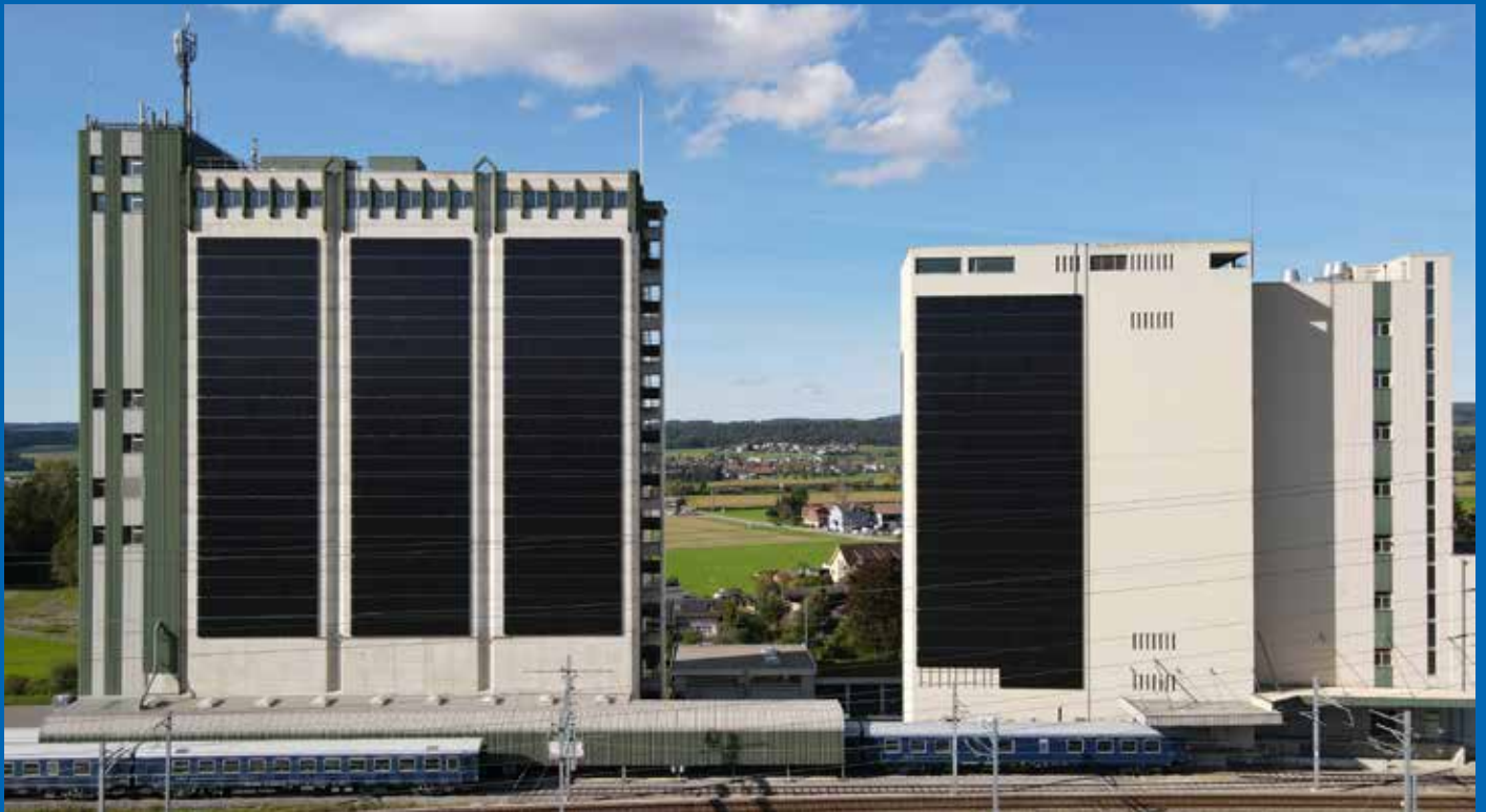
Auf dem Areal der Zwicky AG in Müllheim-Wigoltingen/TG entstand 2021 eine 421 kW starke PV-Fassadenanlage. Sie gewann den Schweizer Solarpreis 2022 (Schweizer Solarpreis 2022).
