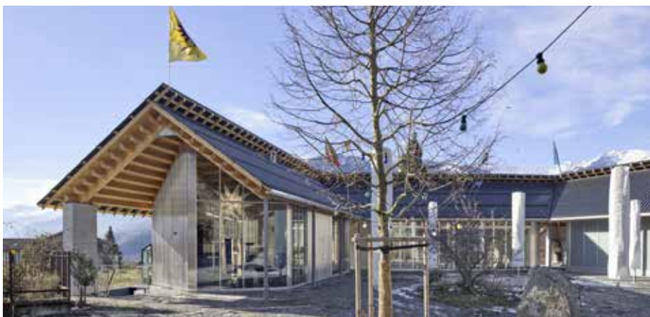
2 Das 68% Weingut überzeugt durch einen gelungenen Materialmix aus Holz, Stahl, Glas, Photovoltaik und Blech.
