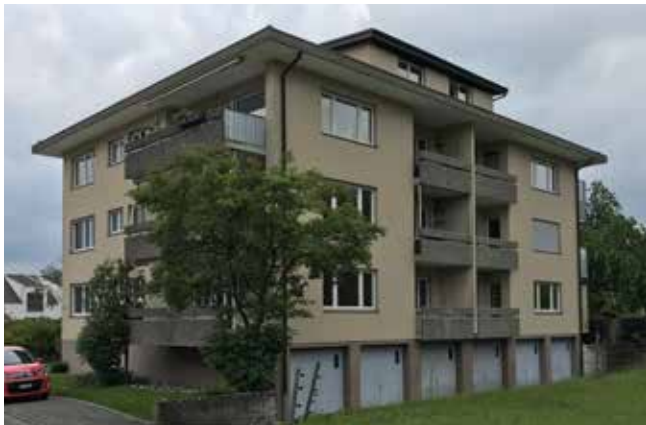
Abb. 1a: Durch die Min.P/PEB-Sanierung des 50-jährigen Mehr-familienhauses (MFH) in Fahrwangen sank der Gesamtenergieverbrauch um 82% von 138'000 kWh fossil-nuklearen Energien auf Null bzw. 25'000 kWh/a CO 2 -freien Solarstrom (Abb. 1a: EW-bestätigt, 4.7.2022).
