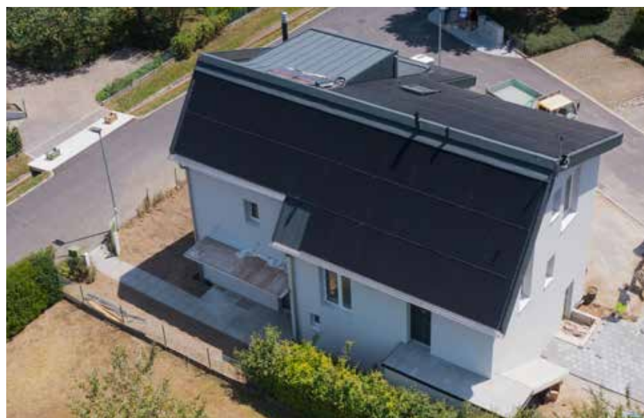
1 Rénové en 2022, le bâtiment est non seulement esthétique, mais produit également 22'300 kWh/an grâce au système photovoltaïque intégré de 26.5 kWc. Cela signifie qu'il couvre plus de 187% de ses propres besoins énergétiques.
