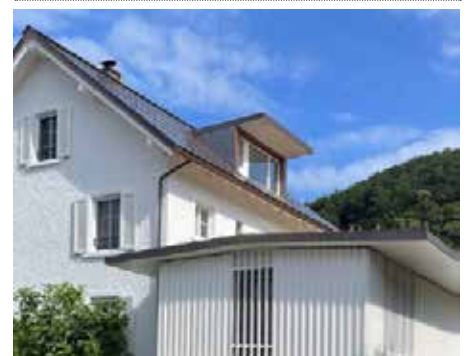
2 Die 20.9 kWp-PV-Anlage erzeugt 17'800 kWh/a und garantiert eine Eigenenergieversorgung von 118%.
