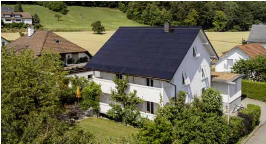
1 Das 100-jährige PlusEnergie-EFH in Würenlos/AG wurde 2021 um eine Vogelzucht von 120 m 2 erweitert und mit einer ganzflächig vorbildlich integrierten Solaranlage versehen.
