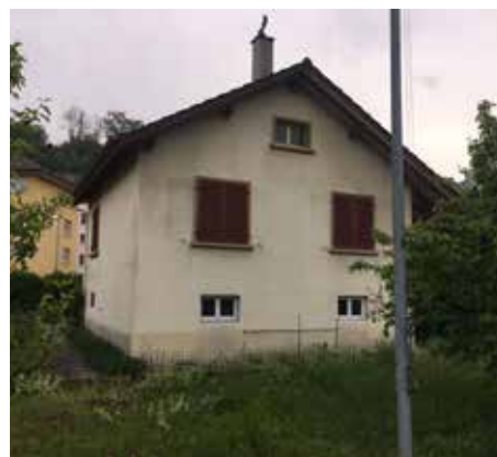
2 Le bâtiment avant rénovation.
