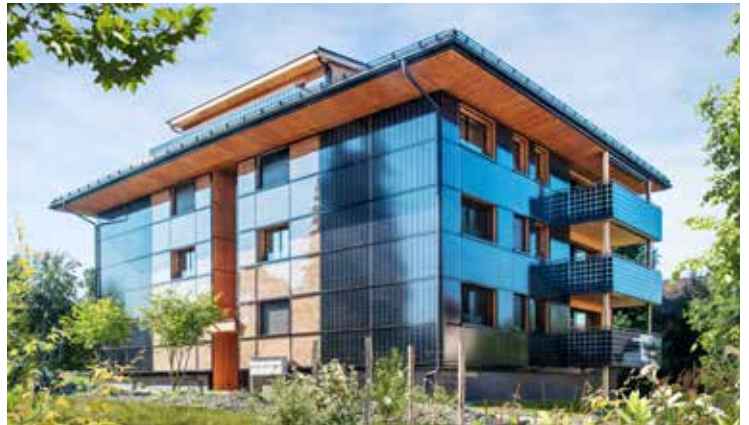
Abb. 1b: Die ganzflächig integrierten solaren Dach- und Fassadenanlagen generieren mit 78'000 kWh einen Solarstromüberschuss von 53'000 kWh/a oder 315% des Gesamtenergieverbrauchs von 25'000 kWh/a für die 7 Wohnungen des PEB-MFH (vgl. nachstehende Abb./Tabelle).
