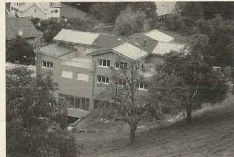
Garagen- und Wohngebäude mit 134 m 2 Sonnenkollektoren, Stückholzkessel und Regenwassernutzung. Foto: Christine Kocher
