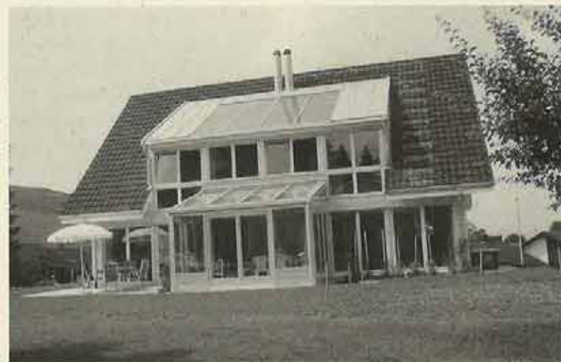
Solaranlage Niedrigenergiehaus Familie Hauser, Oberhofstettenstrasse 90c, 9012 St. Gallen
