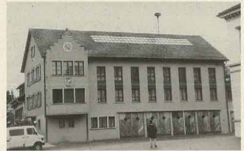
Die erste von der Gemeinde Rheinau bewilligte 3 kW-Photovoltaikanlage musste gegen den Willen der Denkmalpflege beim Regierungsrat erkämpft werden und steht heute im Einklang zum Ortsbild auf dem Dach der Gemeindeverwaltung Rheinau.
