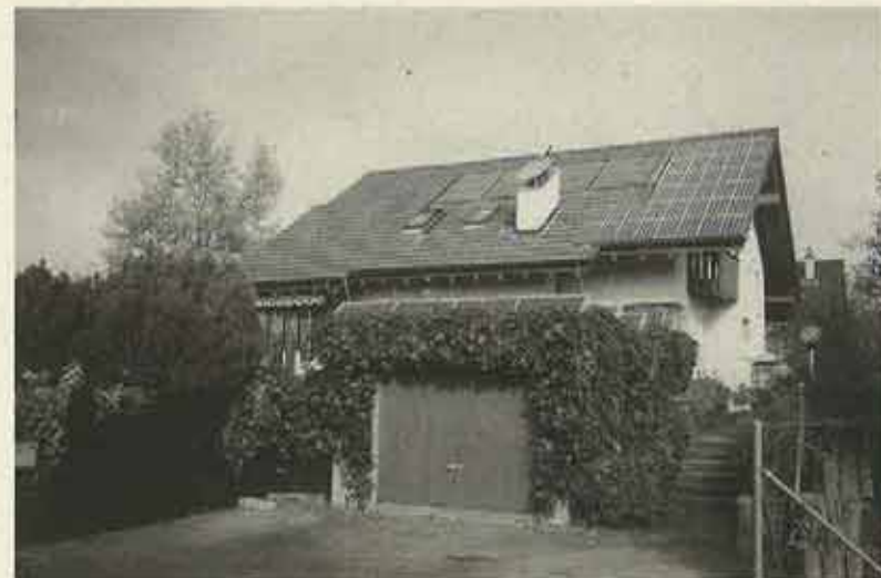
Haus H. Weber, Eigenrain 27, 4107 Ettingen mit 12 m 2 thermischen Kollektoren Baujahr 1983 und 2,6 kW-Photovoltaik-Anlage Bj. 1992
