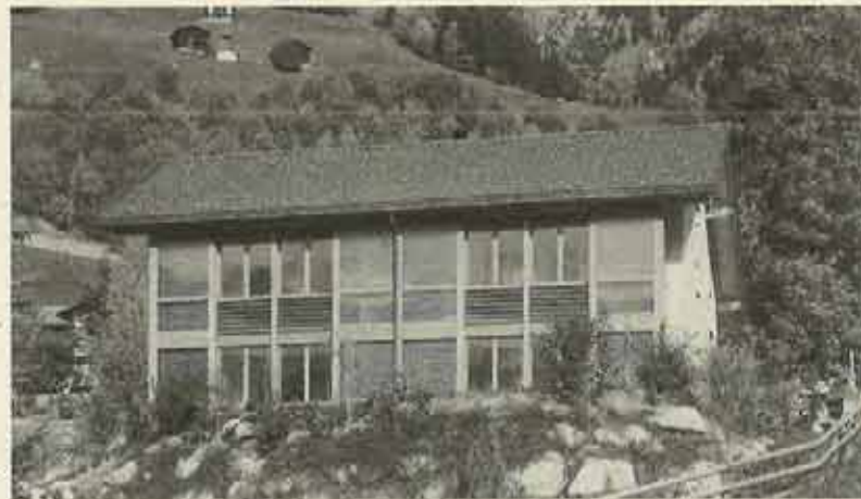
Haus Candinas in Rabius mit integrierten Warmluftkollektoren.
