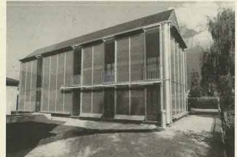
Hinterlüftete Südfassade ausgebildet als riesige Kollektorfläche am Solarhaus in Domat/Ems.
