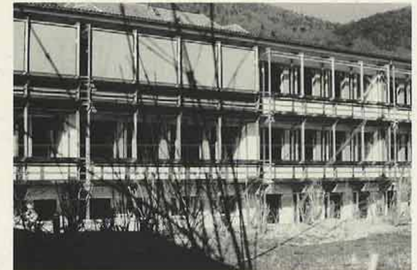
Schulhaus II, Laupersdorf mit 6,9 kW-Photovoltaikanlage
