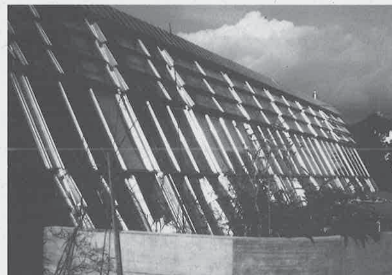
Solarhäuser WBG Wydacker, Zollikofen/BE: Ansicht schräge Wintergartenfassade mit Photovoltaikanlage im Firstbereich
