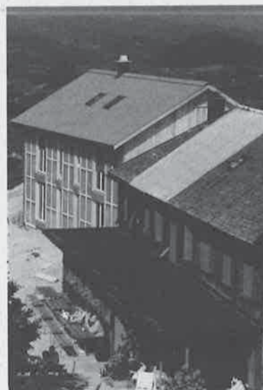
Hundwilerhöhe: Restaurant und Wohn-/Lagergebäude
