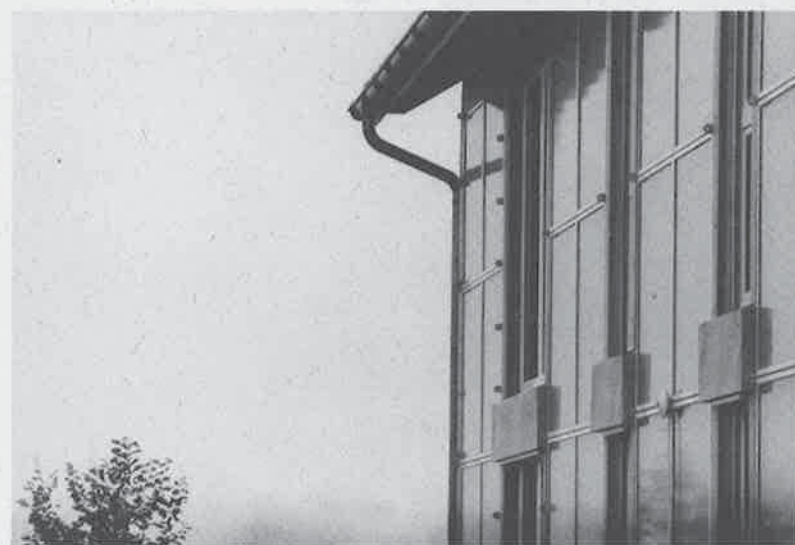
TWD - Transparente Wärmedämmung am Beispiel «Wohn- und Lagerhaus Hundwilerhöhe»
