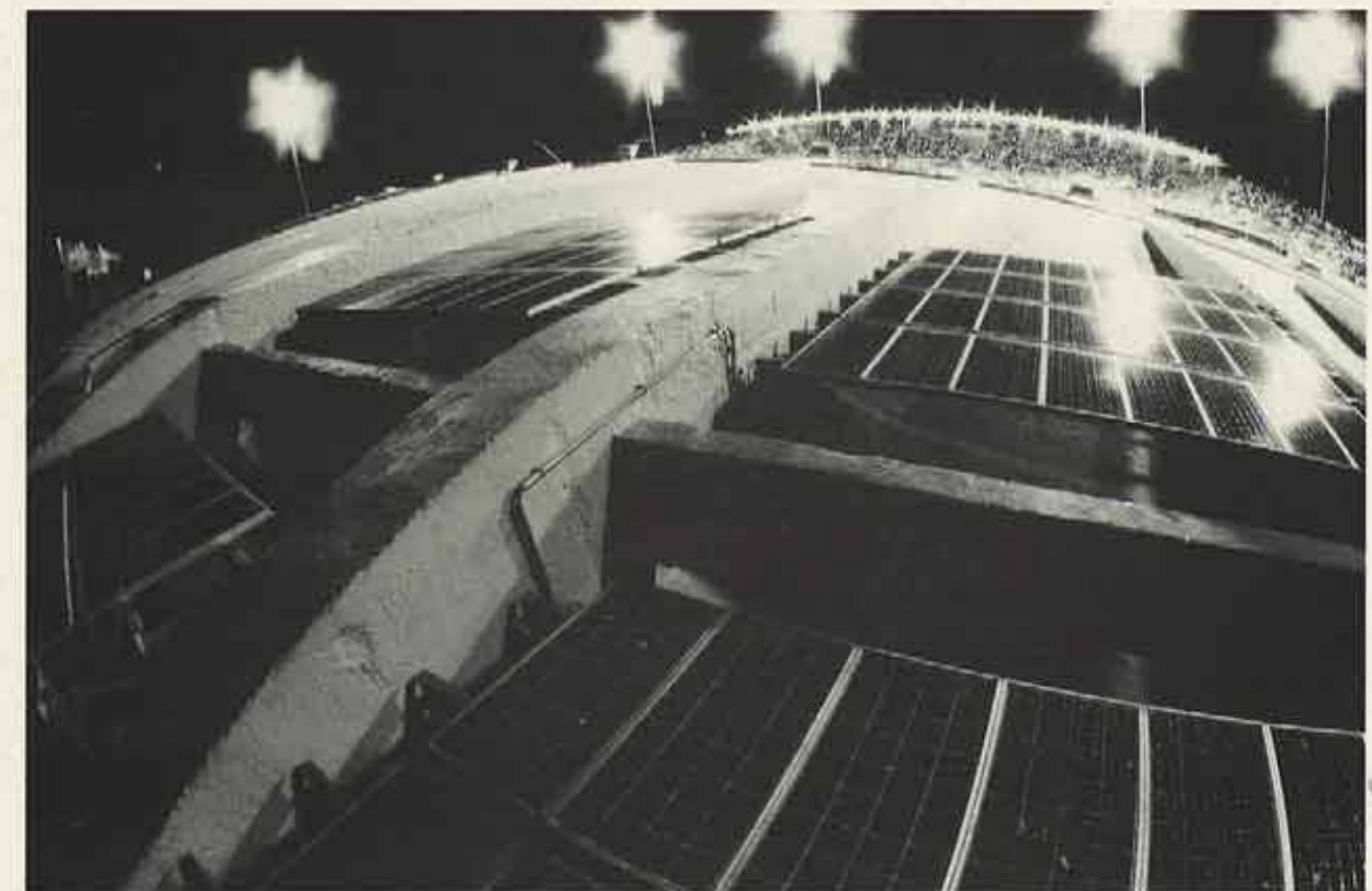
La toiture du «Stade Olympique» Pontaise, Lausanne; Station photovoltaïques de 1296 panneaux Photowatt PWX5000, 65 kWp; 24 capteurs thermiques (48 m 2 )
