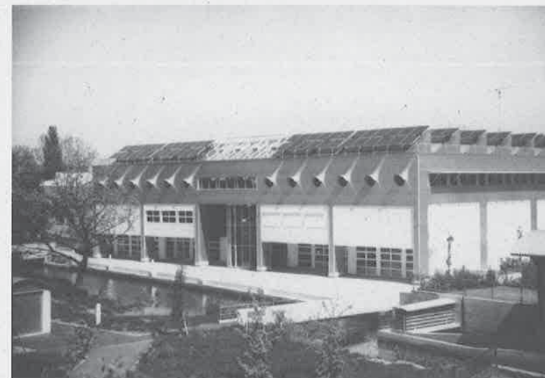
Photovoltaik-Testzentrum in Burgdorf: Auf dem Neubau der Abteilung Elektrotechnik befindet sich die 60 kWp-Photovoltaik-Testanlage der ISB.
