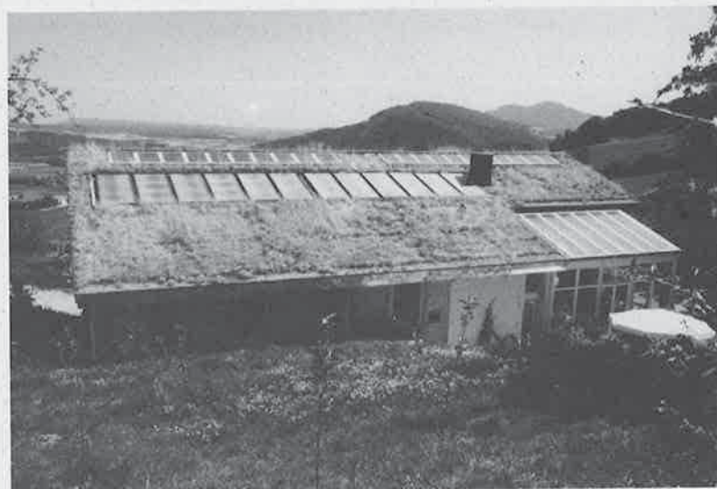
Hof Strickmatt, Bennwil; Ansicht Wohnhaus mit Wintergarten Sonnenkollektoranlage von 36 m 2
