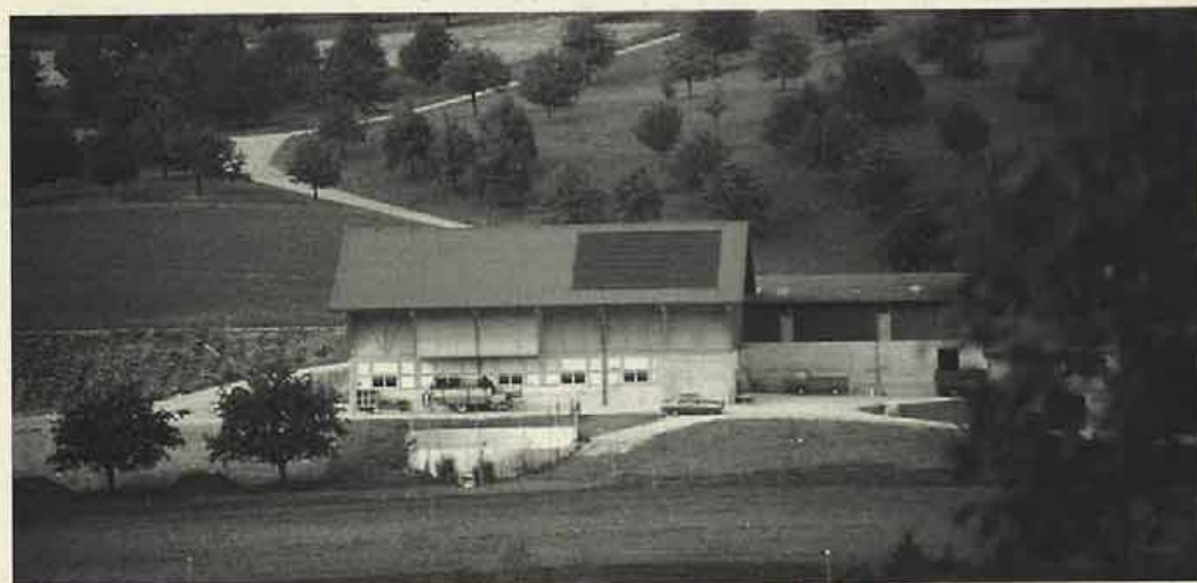
Schweizer Solarpreis 1994 der Kategorie "Eigentümer, Inhaber": Ökonomiegebäude der landwirtschaftlichen Siedlung Langacher in Maisprach/BL: Photovoltaikanlage mit einer Fläche von 100m 2 weist eine Spitzenleistung von 9,8 kW auf.
