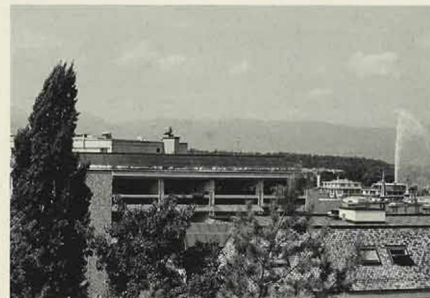
Genève, Prix Solaire Suisse 1992 de la catégorie "Commune/Ville": La progression de la surface des installations solaires thermiques installées sur les immeubles propriétés de la Ville de Genève est remarquable. En effet, depuis la mise en service en 1981 de la première installation solaire pour le préchauffage de l'eau chaude sanitaire, près de 1'700 m 2 de panneaux solaires ont été posés, totalisant 24 installations.
