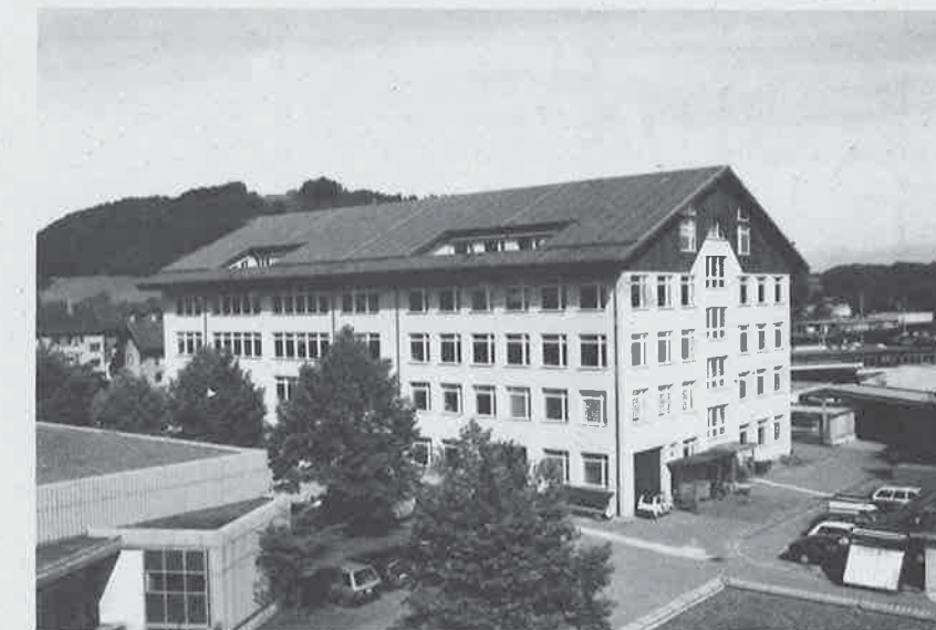
Die Werkstatt der Jenni Energietechnik AG
