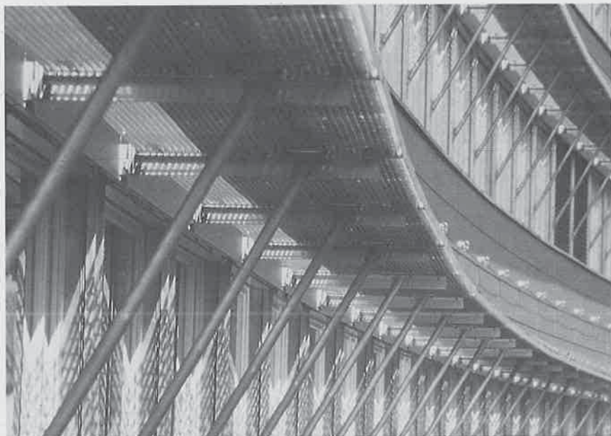
Die "Brise Soleil" mit 16 kW Solarzellen
