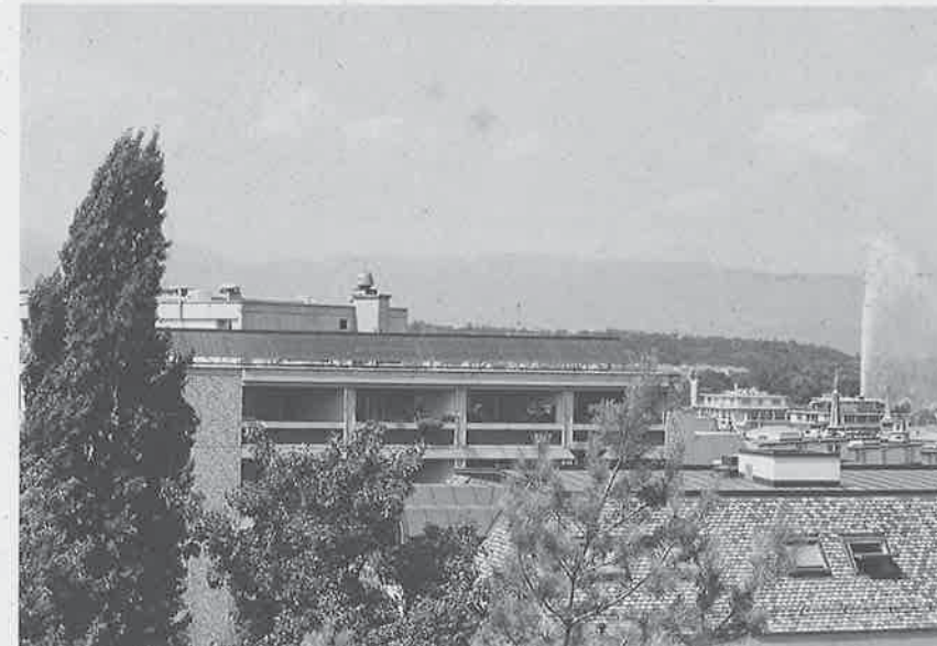
La progression de la surface des installations solaires thermiques installées sur les immeubles propriétés de la Ville de Genève est remarquable.
