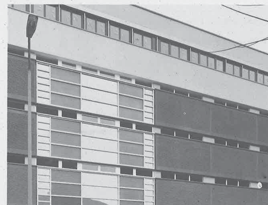
Eine Pionierleistung der Ernst Schweizer AG: Metallfassaden mit integrierten Sonnenkollektoren für die Wassererwärmung bei einem Wohn- und Geschäftshaus in Minusio (3 Wohnungen und 70 Arbeitsplätze)
