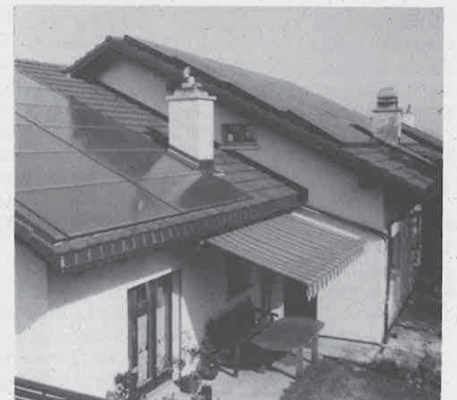
Das Doppel-Einfamilienhaus der Familie Girsberger: Vorn die Kollektor-Anlage für Heizung und Warmwasser, auf dem hinteren Dach die Photovoltaik-Anlage. Das Haus wurde bereits von Anbeginn als Energiespar-Haus konzipiert, alle Wände und Decken über Niveau bestehen ausschliesslich aus Gasbeton, Aussen-Wände mit einer Stärke von 40 cm; die Isolierfenster mit 3-fach-Verglasung wurden absichtlich etwas klein gehalten, sie sind mit Roll-Läden versehen.
