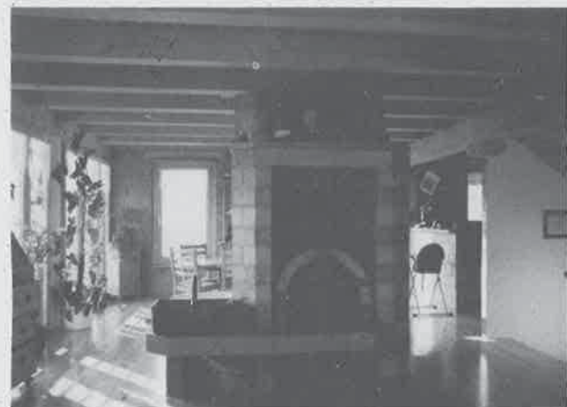
Wohnzimmer mit im Hypokaustenturm eingebautem Grundofen.
