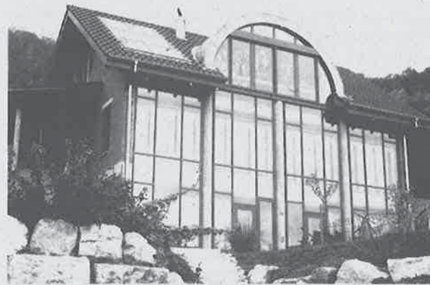
Südfassade Sonnenhaus mit Fensterkollektor und geöffneten Absorberlamellen.
