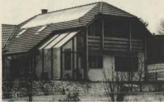
Anlagebeispiel: Neubau mit Solarsystem Jenni.
