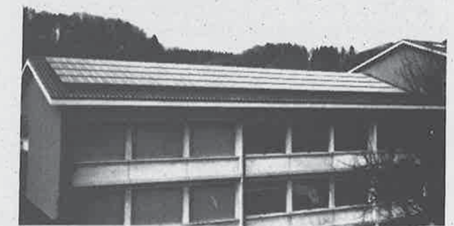
Anlage auf Giebeldach. Solarkraftwerk Wohlen Hinterkappelen. Anlagengrösse: 9,6 kW mit AEG Modul PQ 40-50D 50 W. Wechselrichter: 3 x Solcon 3300. Die Tragstruktur dieser Anlage wurde mit HRS-Profil gebaut.
