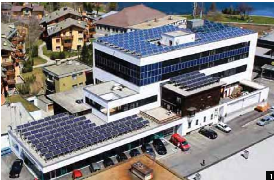
1: Die Solaranlagen auf dem sanierten Wohn- und Geschäftshaus der Malloth Holzbau AG erbringen 35% des Gesamtenergiebedarfs.
