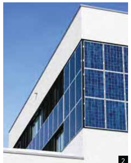
1: Die Solaranlagen auf dem sanierten Wohn- und Geschäftshaus der Malloth Holzbau AG erbringen 35% des Gesamtenergiebedarfs.
