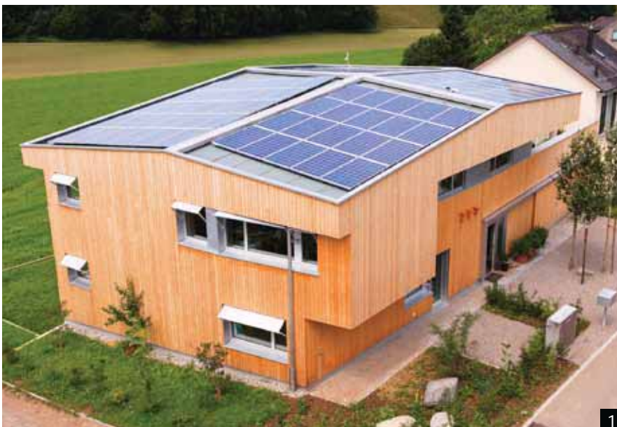
1: Der PlusEnergieBau an der Frobergstrasse produziert rund 1'000 kWh/a mehr, als die Bewohner jährlich an Warmwasser, Heizung und Haushaltsstrom konsumieren.
