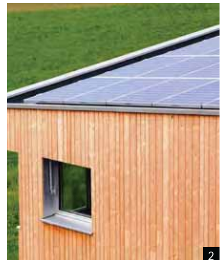
1: Der PlusEnergieBau an der Frobergstrasse produziert rund 1'000 kWh/a mehr, als die Bewohner jährlich an Warmwasser, Heizung und Haushaltsstrom konsumieren.
