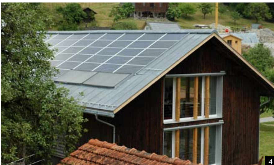
1 + 4: Die vorbildlich und sorgfältig integrierte Solaranlage auf der Ostseite (1) des Dienstleistungsgebäudes und die Anlage auf der Westseite (4) generieren insgesamt 31'557 kWh/a. Die 5 m 2 solarthermische Anlage auf der Westseite versorgt das Gebäude zusätzlich mit Warmwasser (4). 2: Ökologisch sanieren heisst nicht auf Arbeitskomfort verzichten. Auch die Innenräume wurden nach dem neusten Stand der Technik saniert. 3: Die rustikale Holzfassade des ehemaligen Stalles blieb auch nach der Sanierung erhalten. 5: Der innovative Haustechnikplaner Hans Luzi Züst hat mit der 207%-Eigenergieversorgung seines PlusEnergiebaus den Schweizer Solarpreis 2009 verdient.
